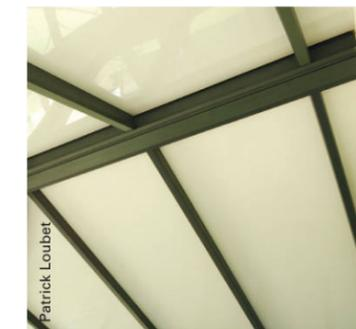
**Les panneaux opaques** (mousse entre deux panneaux aluminium) ne laissent pas passer la lumière et protègent contre la chaleur.
