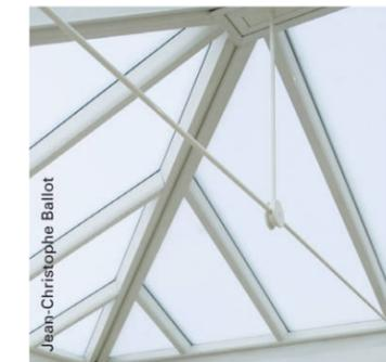
**Les panneaux translucides** diffusent la lumière sans que l'on puisse voir à travers. Réduction de la transmission d'ultraviolets.
