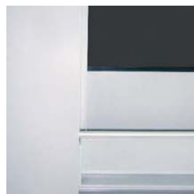
Détail extérieur du châssis : dormant-traverse basse
