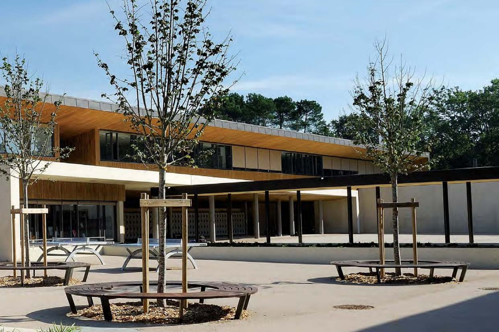
Collège Saint-Paul-lès-Dax - Architecte : Cabinet Hubert Photographe : P. Loubet
