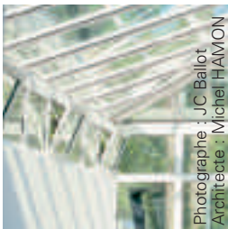
Châssis fixé entre 2 chevrons
